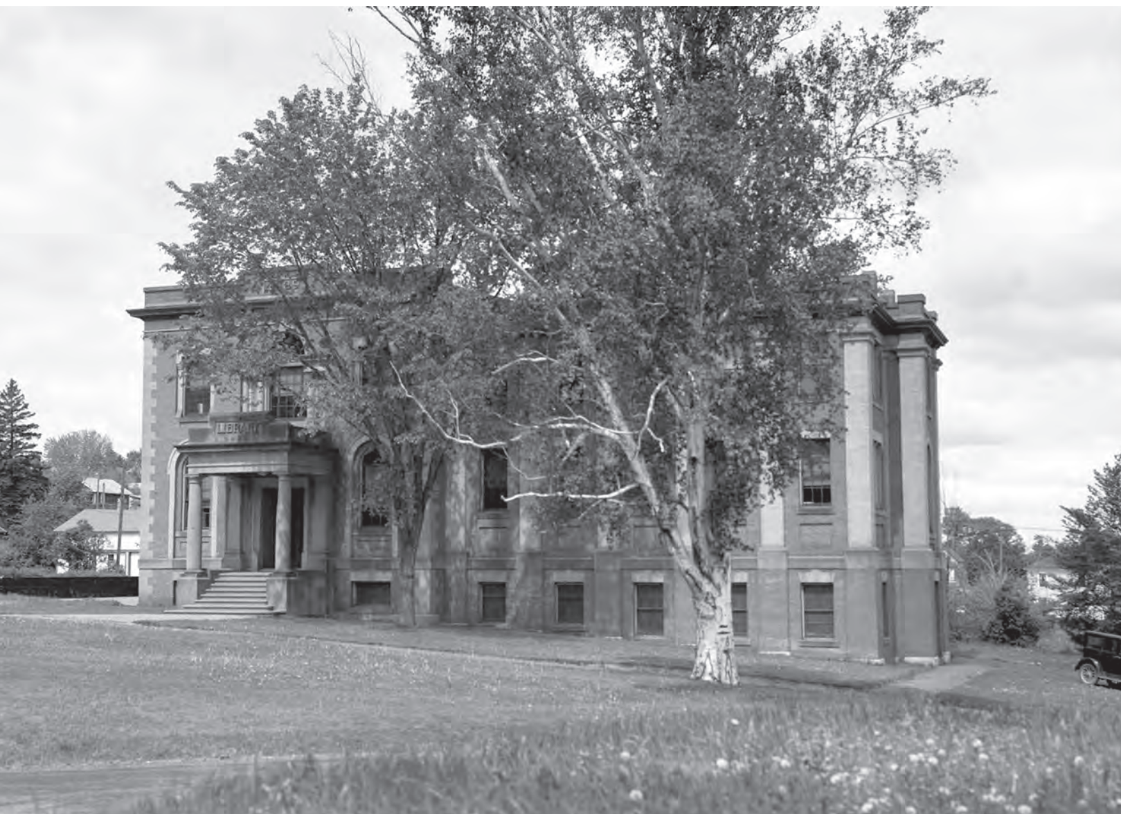
La bibliothèque originale de l'Université du Nouveau-Brunswick a été construite au début des années 1930. En 1951, elle a été renommée bibliothèque Bonar Law-Bennett. Aujourd'hui, ce bâtiment abrite les Archives provinciales du Nouveau-Brunswick. Cette photo de la bibliothèque a été prise en 1941. (P93-Y-122, New Brunswick Travel Bureau County photograph series.)
